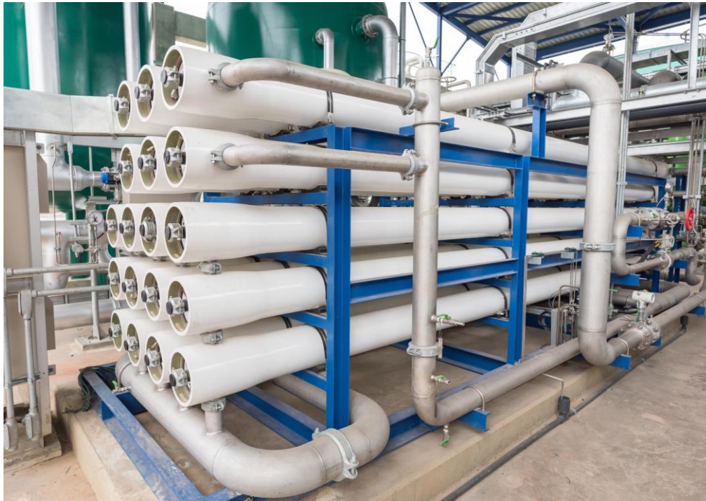
Fig.3: dissalatore dell'acqua di mare con una produzione di 2.000 m 3 /giorno (Gajarda srl)
