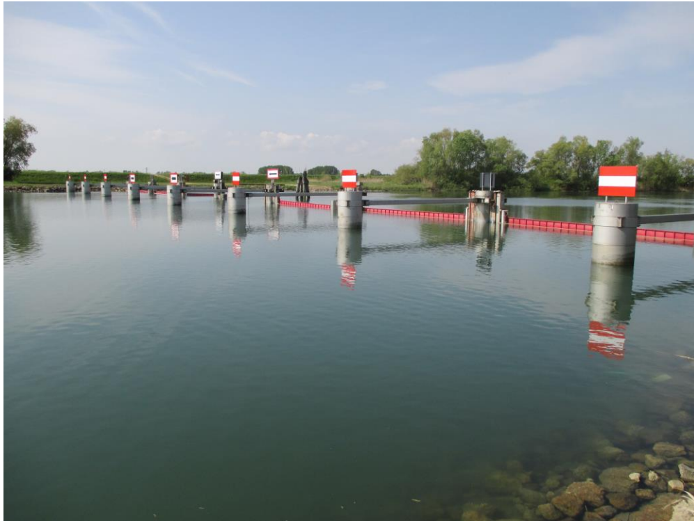
Sbarramento anti cuneo salino di Boara Pisani. Fonte: ANBI.
