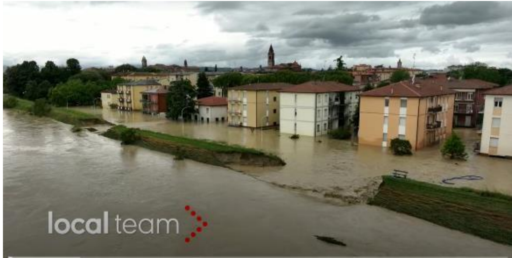
Via Fratelli Bandiera (Faenza - RA) Rottura d'argine del Fiume Lamone
