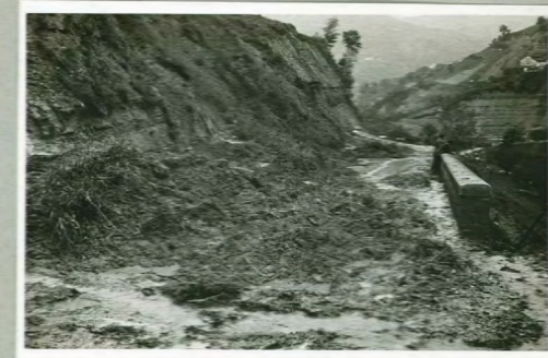
Modigliana - frana sulla strada Monte Trebbio
