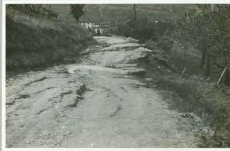
Tredozio - la strada provinciale del Monte della Busca distrutta dalla frana
