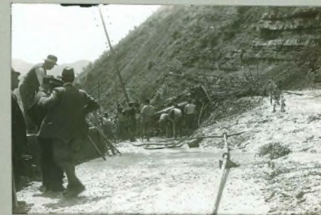
Brisighella - frana in località Pendici
