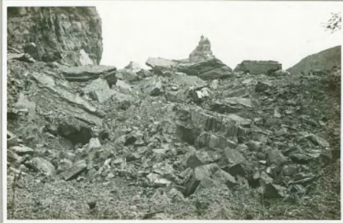
Modigliana - frana di Cà Risanello
