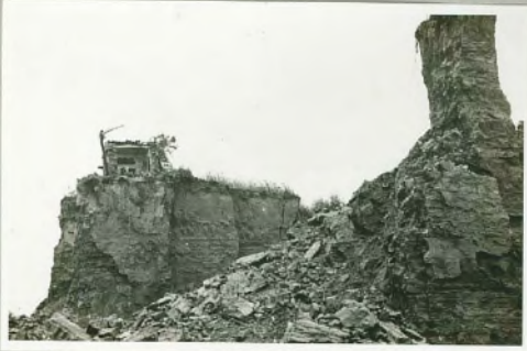
Modigliana - frana di Cà Risanello
