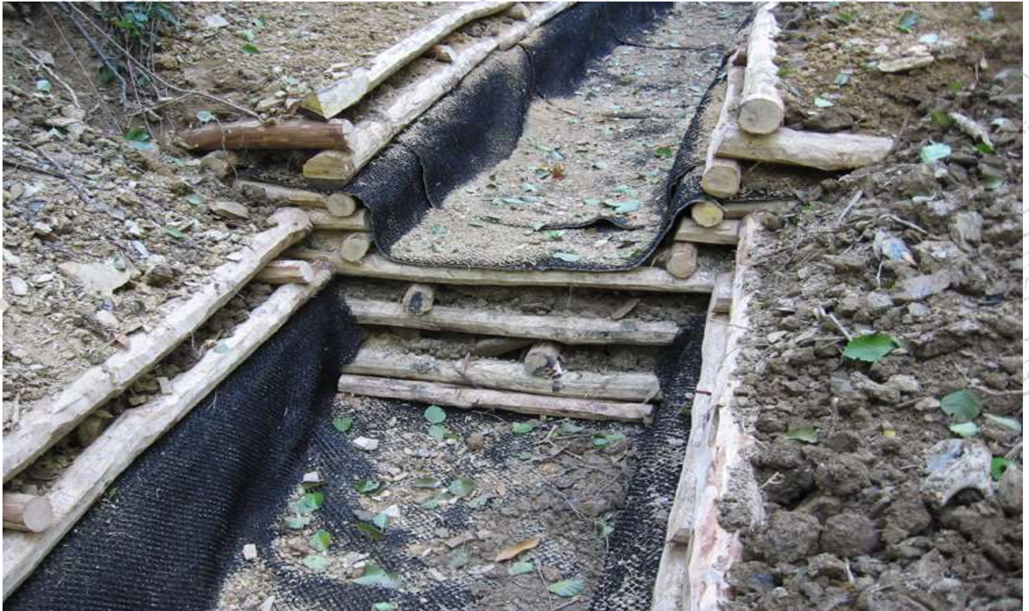
Figura - «canaletta in legname e pietrame» (da F. Boccalaro, 2022)
