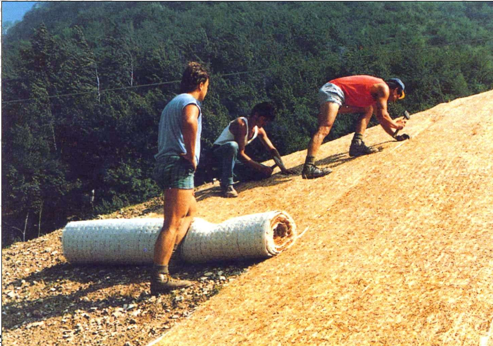
Figura - Rivestimento vegetativo naturale con stuoie in fibra di paglia (da Maccaferri)
